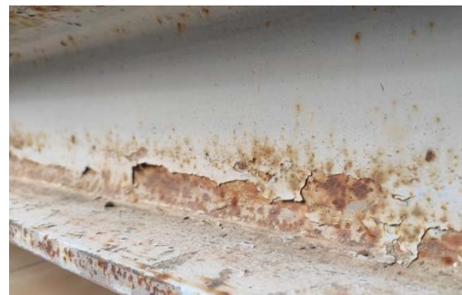
Figura 1. Diagrama de Evans donde se muestra la despolarización de la reacción catódica en zonas de mayor concentración de oxígeno. Ejemplo de estructura donde actúan pilas de aireación diferencial.
