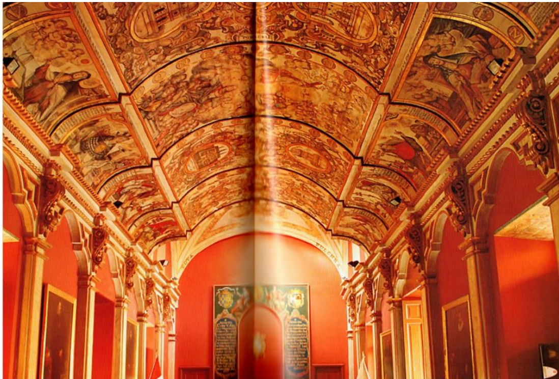
Estado final general del Salón de Grados recuperado.
