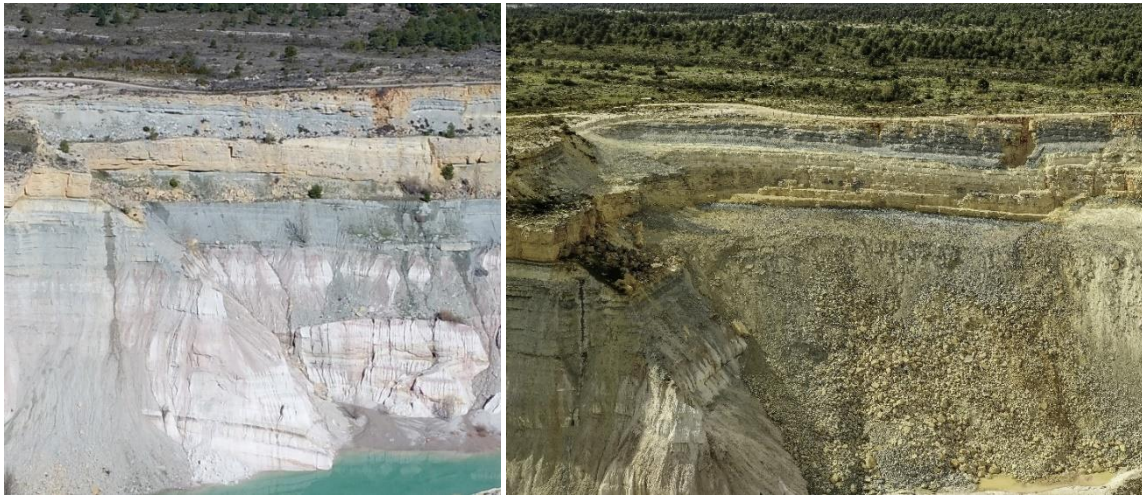
Figura 3. Restauración geomorfológica del antiguo frente de explotación de la mina Santa Engracia (Peñalén, Guadalajara), realizada con el método del Talud Royal. Izquierda, situación pre-restauración en el año 2020 (fotografía de Diedro). Derecha, situación post-restauración en el año 2024 (fotografía de M.A. Langa).
