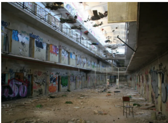
Foto nº1: Galería de la antigua cárcel de Carabanchel
