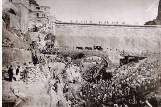
Obras del Canal de Isabel II: construcción de la presa del Pontón de la Oliva, 1855.
