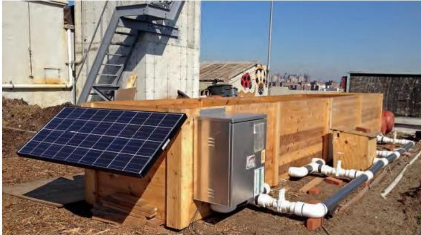
Sistema de aireación forzada por energía solar en composteras de madera.
