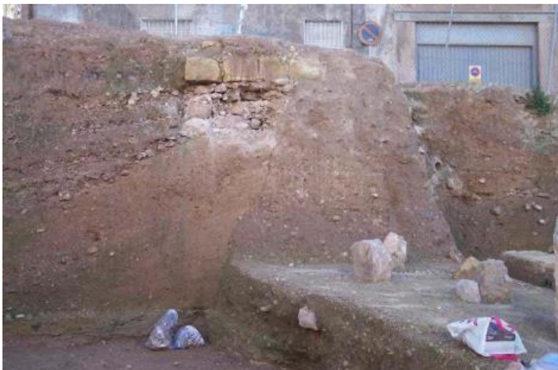
Figura 8. Muralla de tierra apisonada en C/ Adarve (Molinete). Nótase en el corte estratigráfico el talud adosado a su frente, producto de una reparación posterior (Munuera Navarro 2010: 593).
