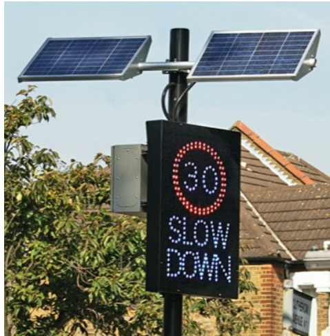
Figura 65: Lifi solar en la señalización vial.
