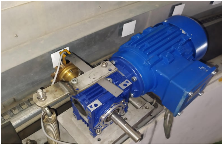
Figura 3.10: Montaje de uno de los motores de movimiento de la cúpula donde se puede apreciar el eje de salida con el piñón que engrana en la cremallera y el sensor magnético situado justo encima del piñón. (Fuente: elaboración propia)
