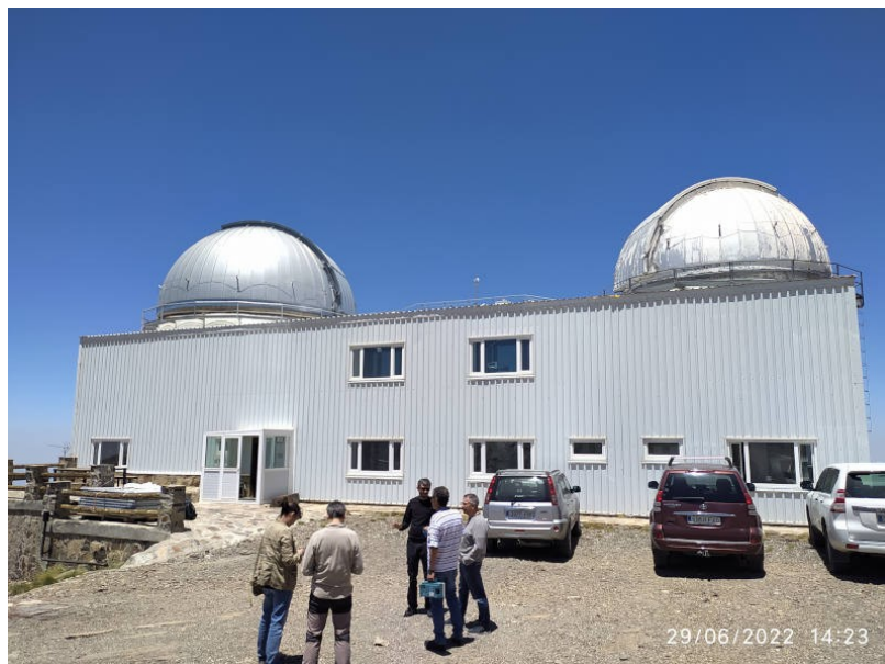
Figura 1.1: Instalaciones del OSN desde el exterior. (Fuente: elaboración propia)
