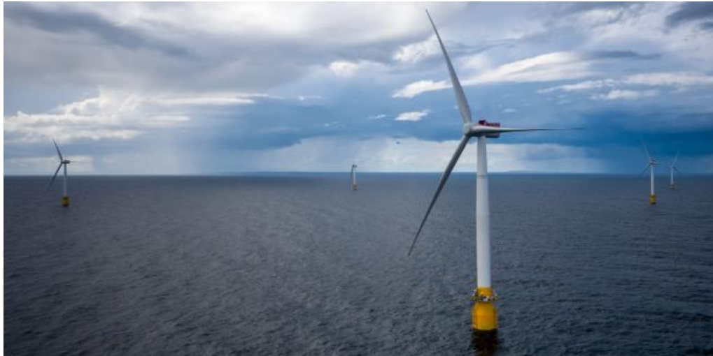
Figura 1.3.- Parque eólico Hywind Scotland
