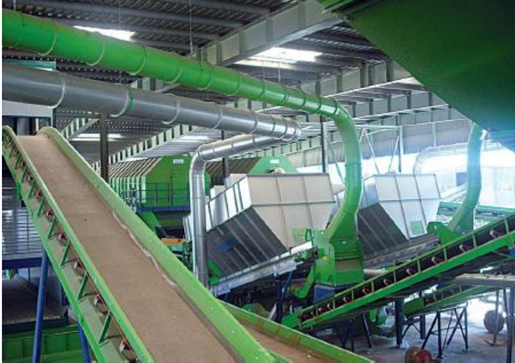
Figura 2.1: Centro de tratamiento de residuos de Villarrasa
