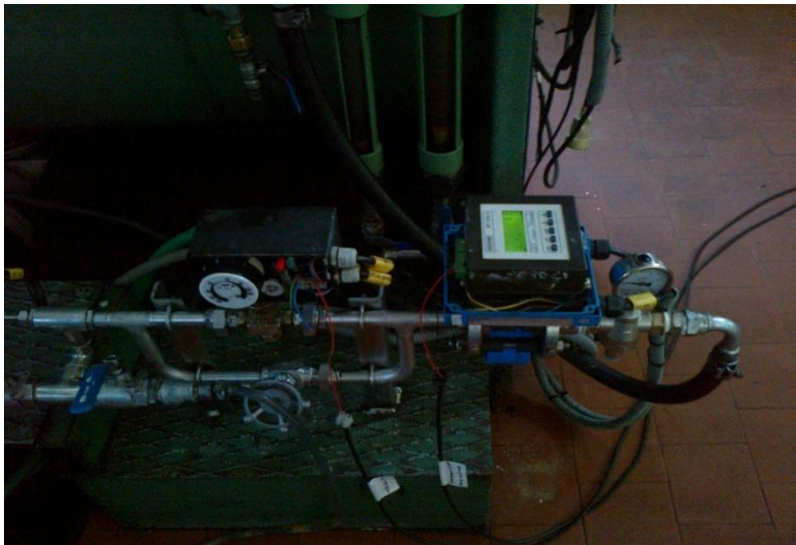
Figura 35. Circuito de adición de agua a la masa de aceituna a salida de la termobatidora
