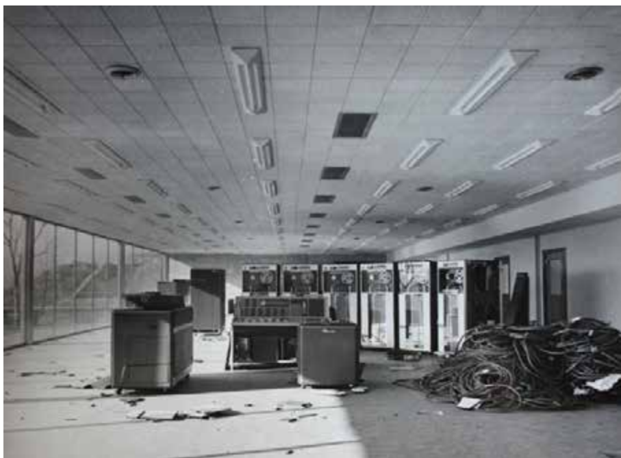
Figura 9. Instalación de la 7090 en el edificio CCUM.
