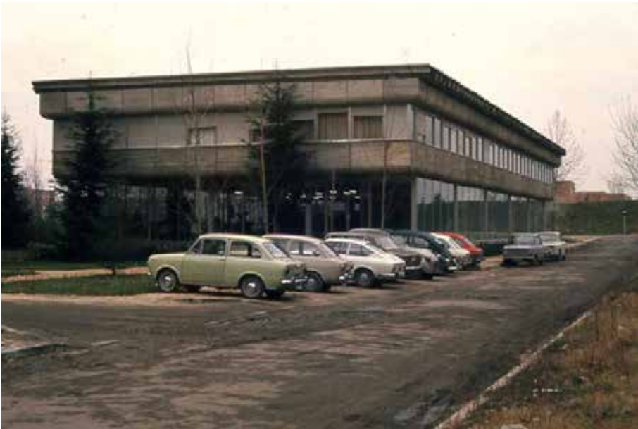
Figuras 6. Edificio CCUM en 1969.
