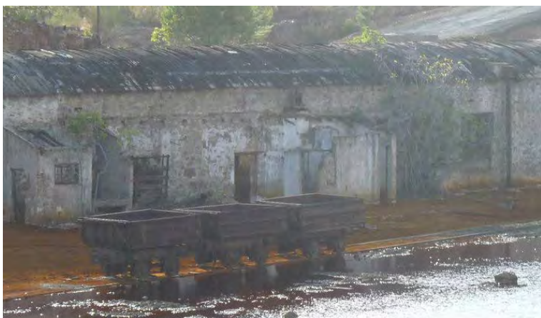
Figura 4. Una muestra de patrimonio a rehabilitar. Ríotinto.
