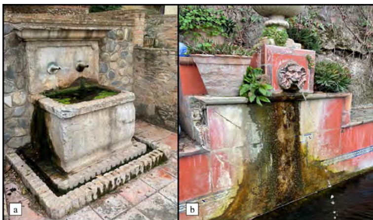
Figura 3. Estado de conservación en las fuentes del Carmen de Bellavista (entorno de la Alhambra), provocado por la presencia de biopelotas. (2022) (a). Pilón de los dos pinos, (b). Surtidor León Modernista. Fuente: Autoría propia.
