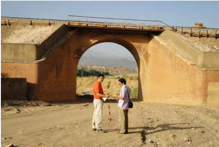
Figura 1. Ejemplo de trabajos de campo. Línea ferroviaria Linares-Almería, cerca de la estación de Guadix. Fuente: Colección del autor.
