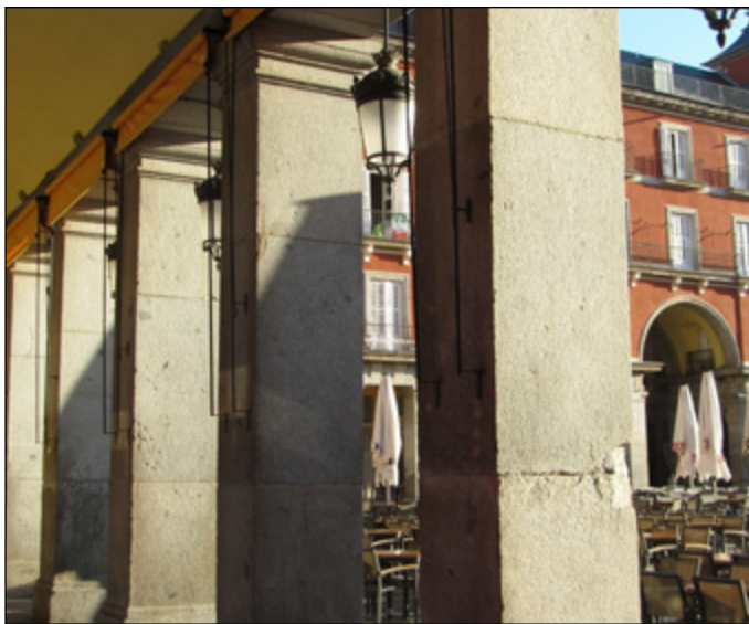
Columnas de la Plaza Mayor en las que se aprecia el deterioro. / David Martín Freire-Lista.
