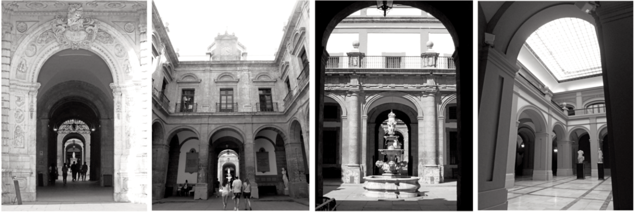
El espacio secuencial de patios como eje vertebrador de la Real Fábrica de Tabacos de Sevilla: vista desde la portada del acceso principal, Patio del Reloj, Patio de la Fuente y patio cubierto con montera acristalada (Fotografía: Carolina Castañeda, 2015).
