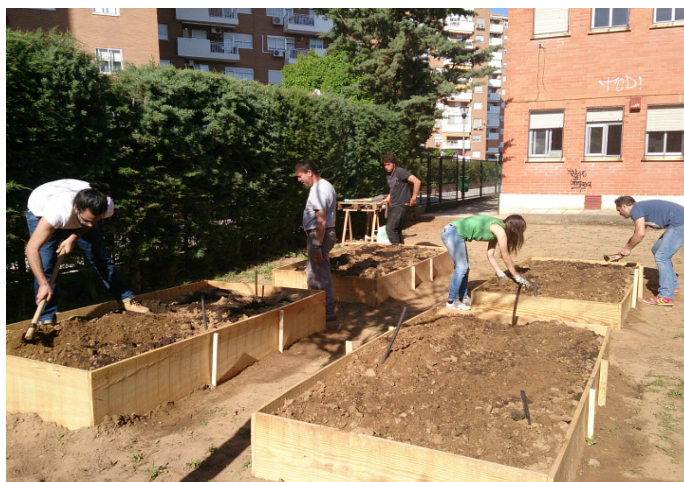
Figura 1. Construcción de las cuatro primeras “camas elevadas”
