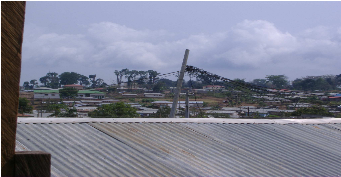
Ilustración 2: Vista panorámica de la barriada popular de Semu, en Malabo. En primer plano, varias conexiones ilegales a la red eléctrica.
