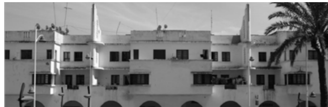
Edificio Vivienda Funcionarios Tetuan 1942 Patricio Musalem
