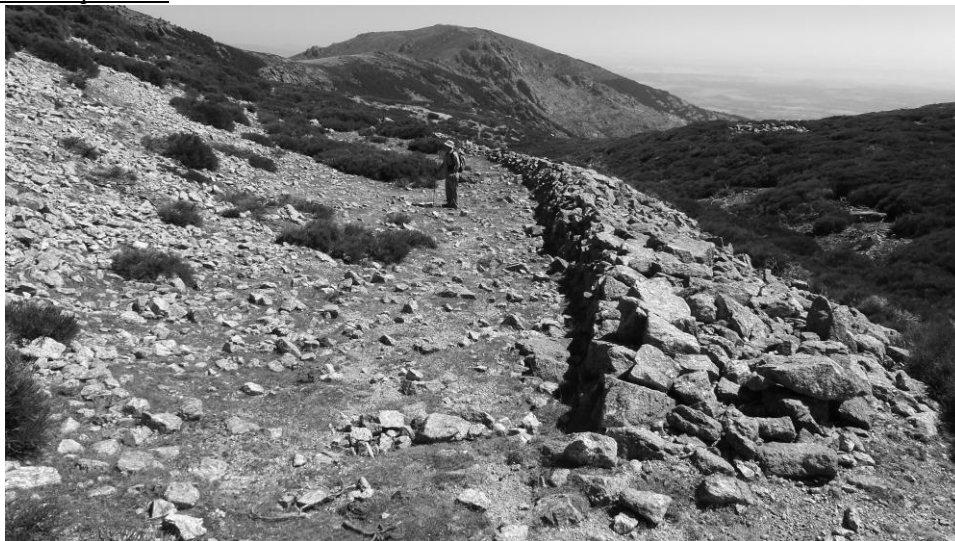
Figura 6. El área frontal del ventisquero del Ratón, enmarcada por el paredón histórico, a finales de verano tras la desaparición de la nieve. Se aprecia su invasión por las formaciones arbustivas de piorno.
