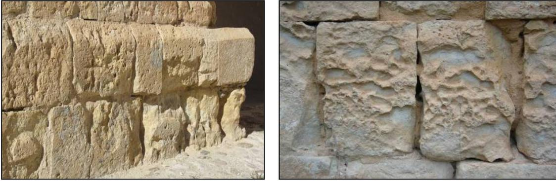
**Figuras 2 y 3.** Iglesia de San Miguel Arcángel en Sotosalbos. Pórtico de mampostería de caliza fuertemente deteriorado por diversos procesos naturales y antrópicos. Se aprecia el apiconado en el acabado. Meteorización y alveolización de la fachada de la ermita Virgen de la Vega (Requijada).
