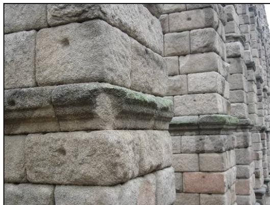
**Figuras 5 y 6.** Detalle del grado de meteorización de la roca sobre la que apoya el acueducto de Segovia. Detalle de bloques de granito del acueducto.
