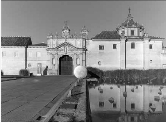
Centro Andaluz de Arte Contemporáneo (Sevilla)
