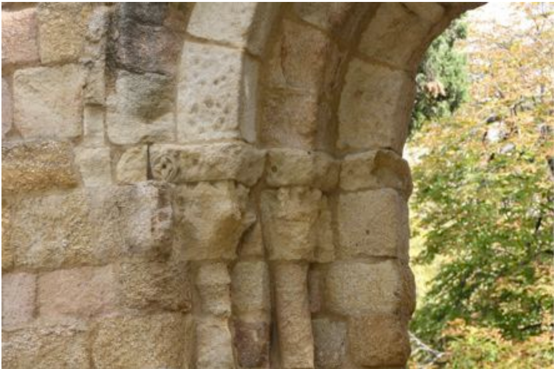
Fig.2. Los restos actuales muestran unas columnas que no se encuentran representadas en la litografía de Velázquez Bosco.
