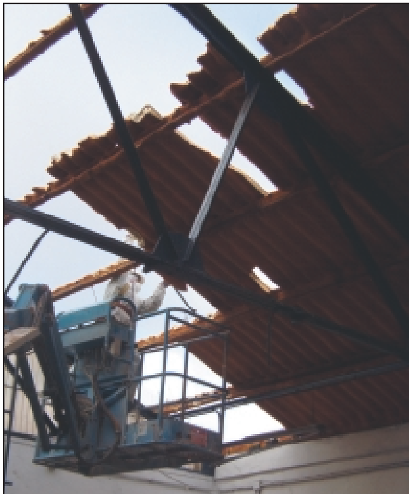
FOTO 9.- LA MANIPULACIÓN DE LAS PLANCHAS DE FIBROCEMENTO CONLLEVA MUCHAS VECES LA UTILIZACIÓN DE MAQUINARIA ADECUADA.
