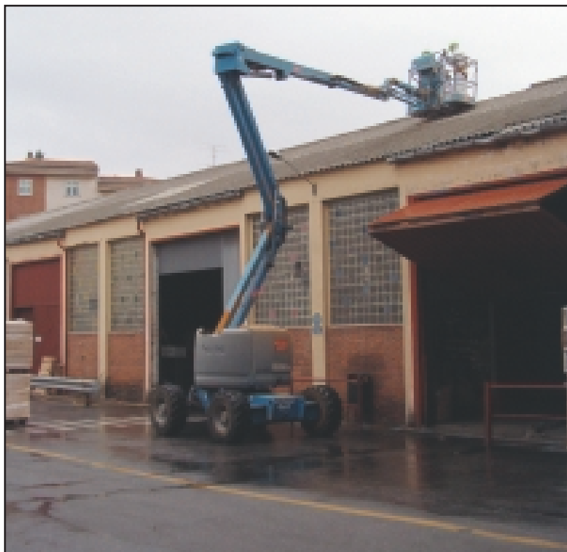
FOTO 10.- PERSONAL CUALIFICADO TRABAJANDO EN UN TEJADO DE FIBROCEMENTO.
