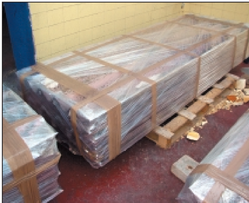
FOTO 8.- PLANCHAS DE FIBROCEMENTO PERFECTAMENTE EMBALADAS Y PREPARADAS PARA SU DEPÓSITO EN VERTEDERO AUTORIZADO.
