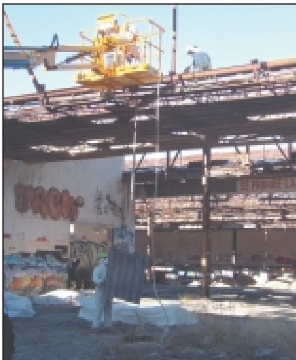
FOTO 5.- DESMONTAJE DE PLACAS DE FIBROCEMENTO.
