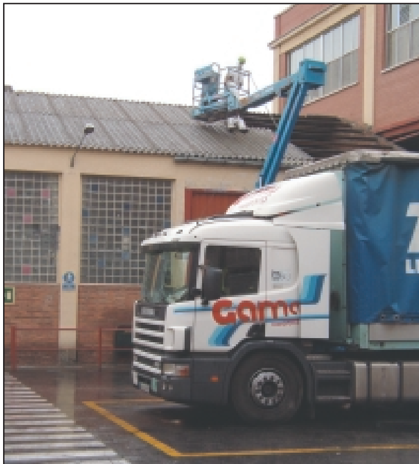
FOTO 12.- RETIRADA DE PLACAS DE FIBROCEMENTO EN EL TEJADO DE UNA NAVE INDUSTRIAL.
