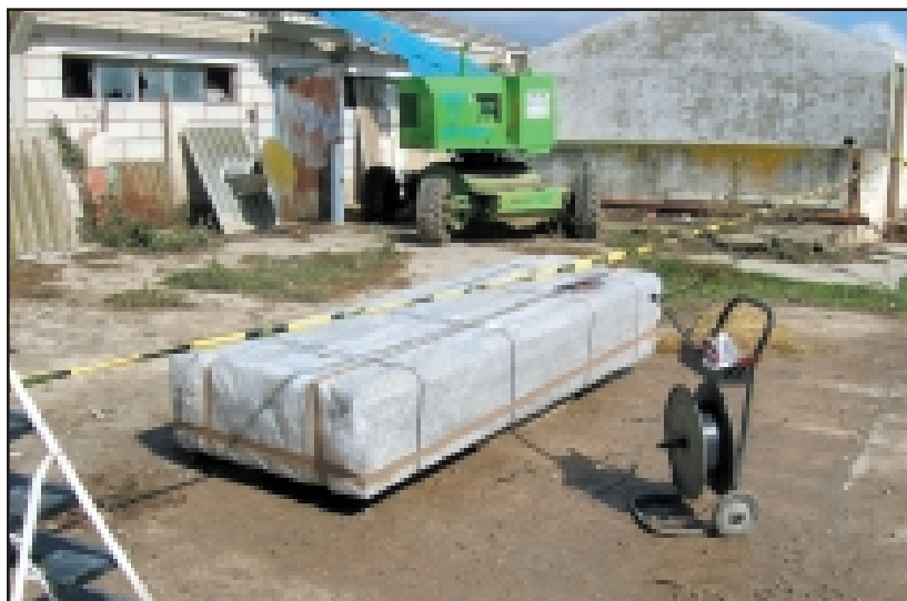
FOTO 13.- PLACAS DE FIBROCEMENTO LISTAS PARA EL TRANSPORTE A VERTEDEROS.
