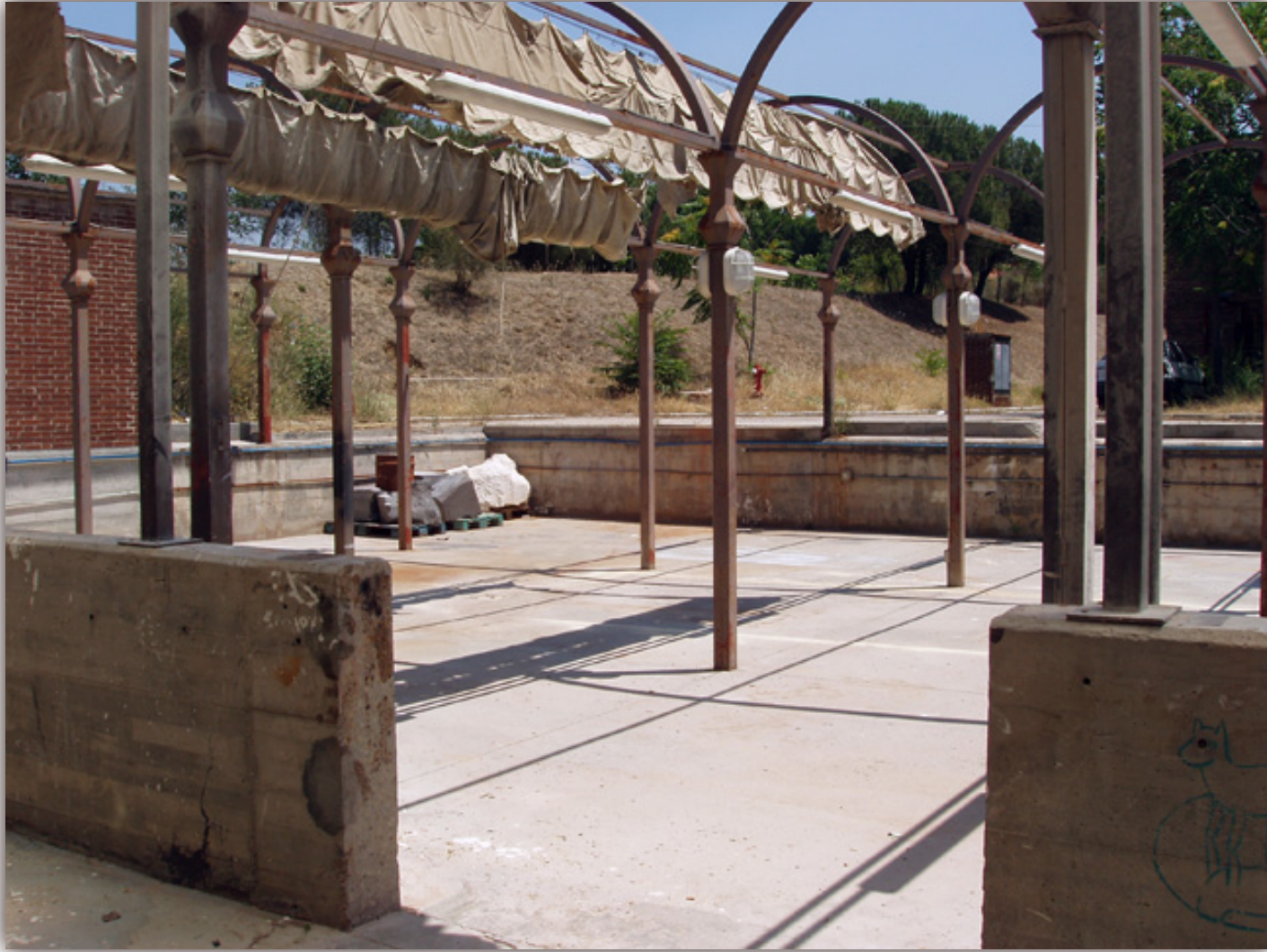
Dos vistas de las instalaciones al aire libre, destinadas a trabajos con piedra y trabajos en general que generen gran cantidad de polvo.
