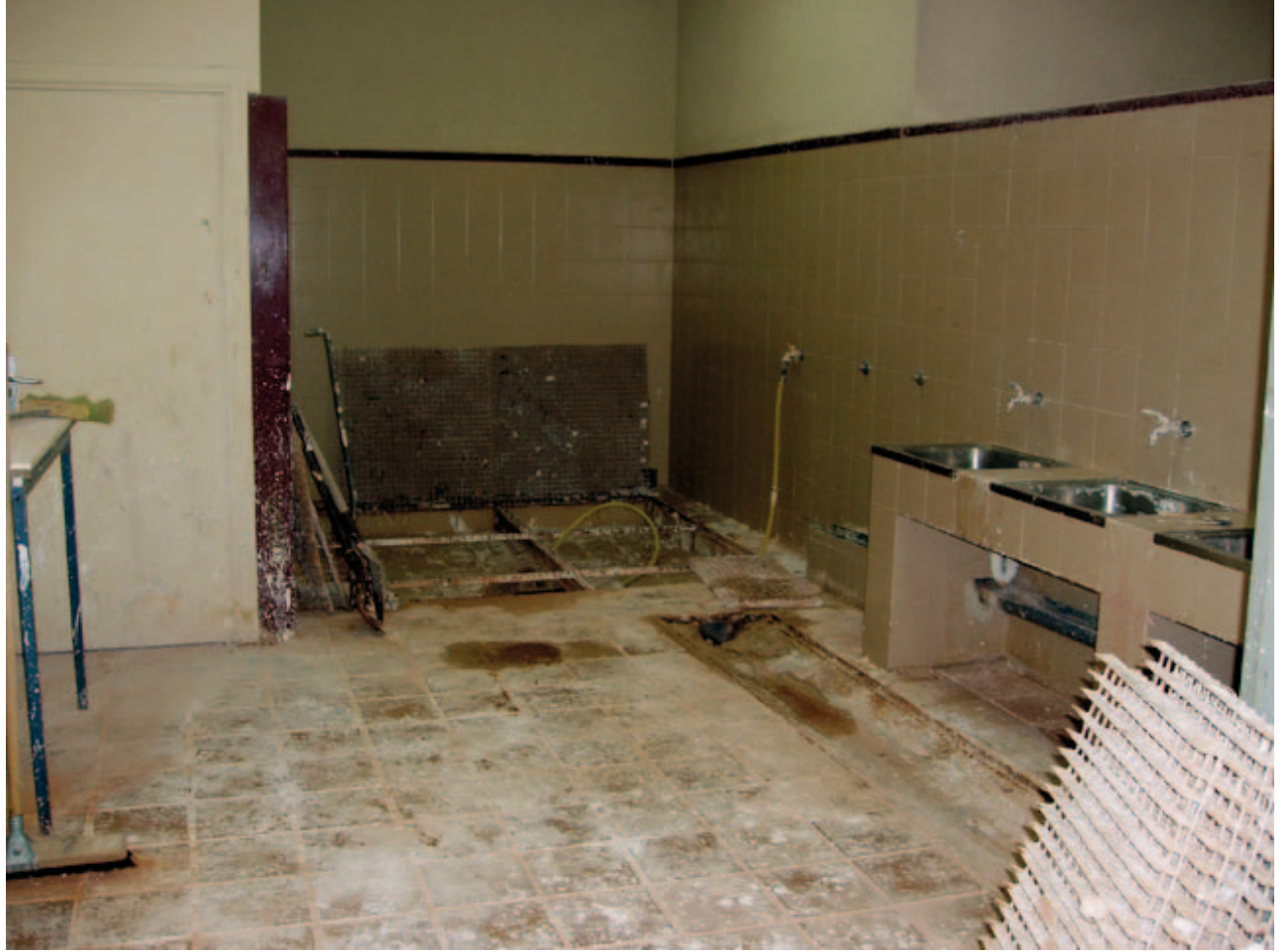
Espacio reservado para vaciado y el trabajo con escayola en general.
