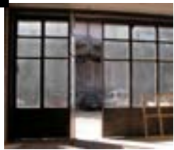
SALIDAS DE EMERGENCIA
