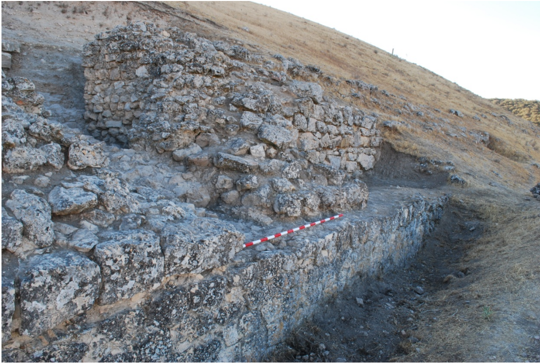
Figura 3. Vista desde el norte de la plataforma de refuerzo construida adosada a la muralla. En primer término, detalle del cambio en el aparejo exterior de esta plataforma al nivel de inicio de la rampa.
