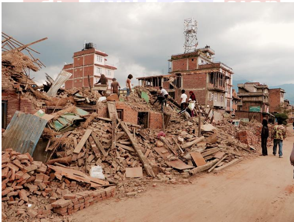
Daños causados por el terremoto en Nepal. Autor: SIM Central and South East Asia .
