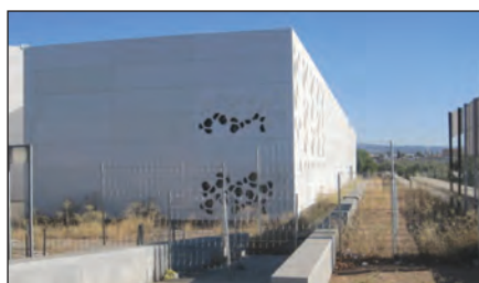
Foto 3. Espacio Andaluz de Creación Contemporánea, Córdoba. El edificio terminado está en espera de inauguración
