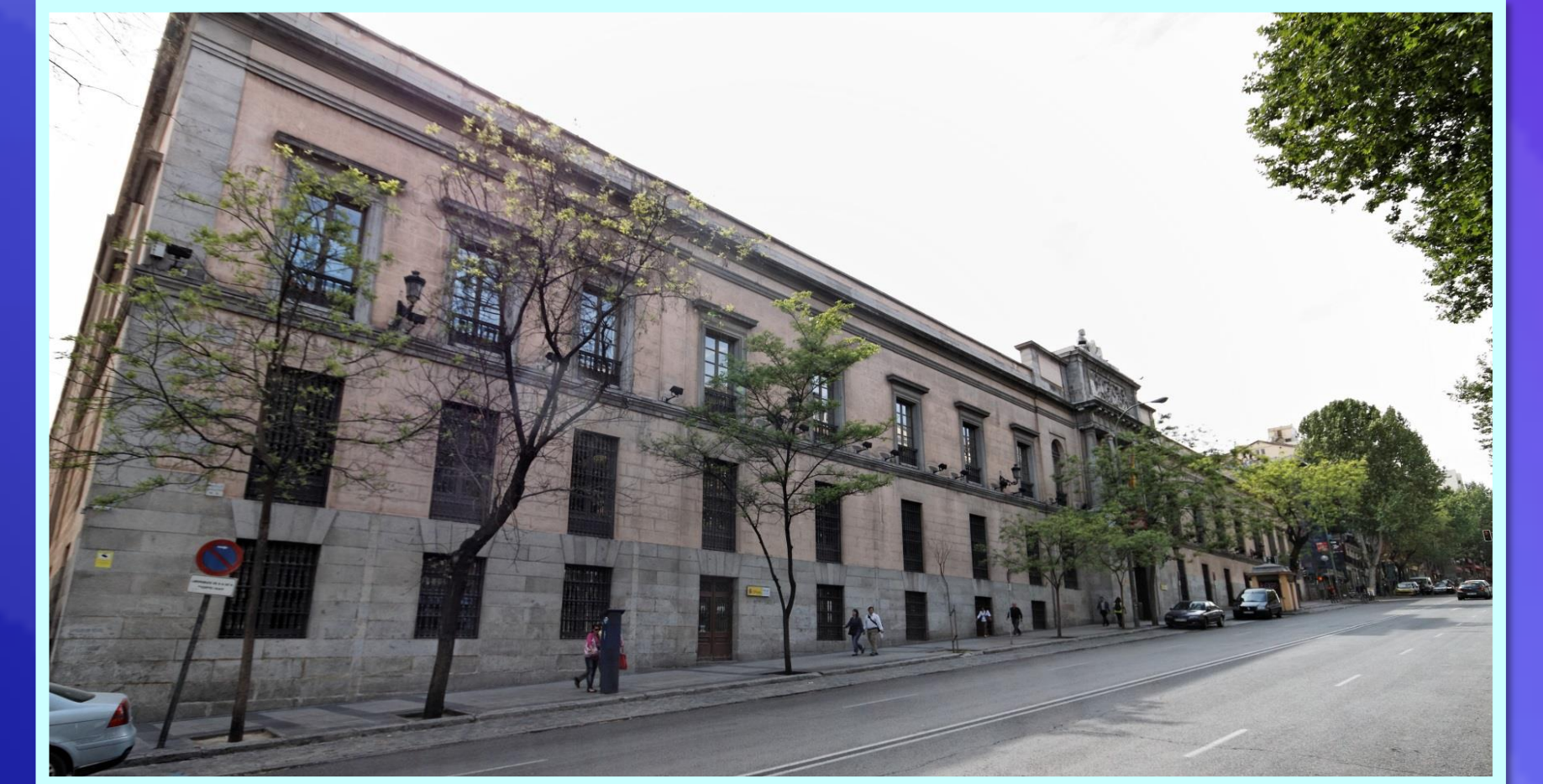
Hospital General de Madrid (San Carlos), glorieta de Atocha
