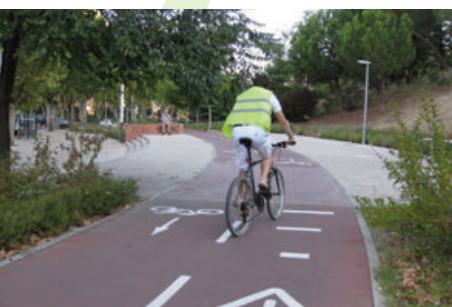
Dos aspectos del carril bici de la Ciudad Universitaria
