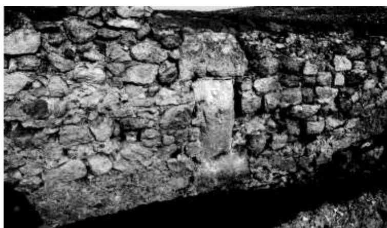
Fig. 5. Oschiri, località di Nostra Signora di Castro. Particolare delle mura in opera a telaio (Mastino et al. , 2004).
