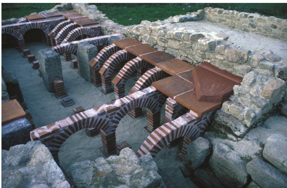
Fig. 4. Reconstrucción “en ruina” de la suspensura del ambiente termal. Fotografía: M. Xusto, 1996.
