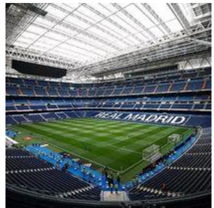
ESTRENO DEL TECHO RETRÁCTIL
