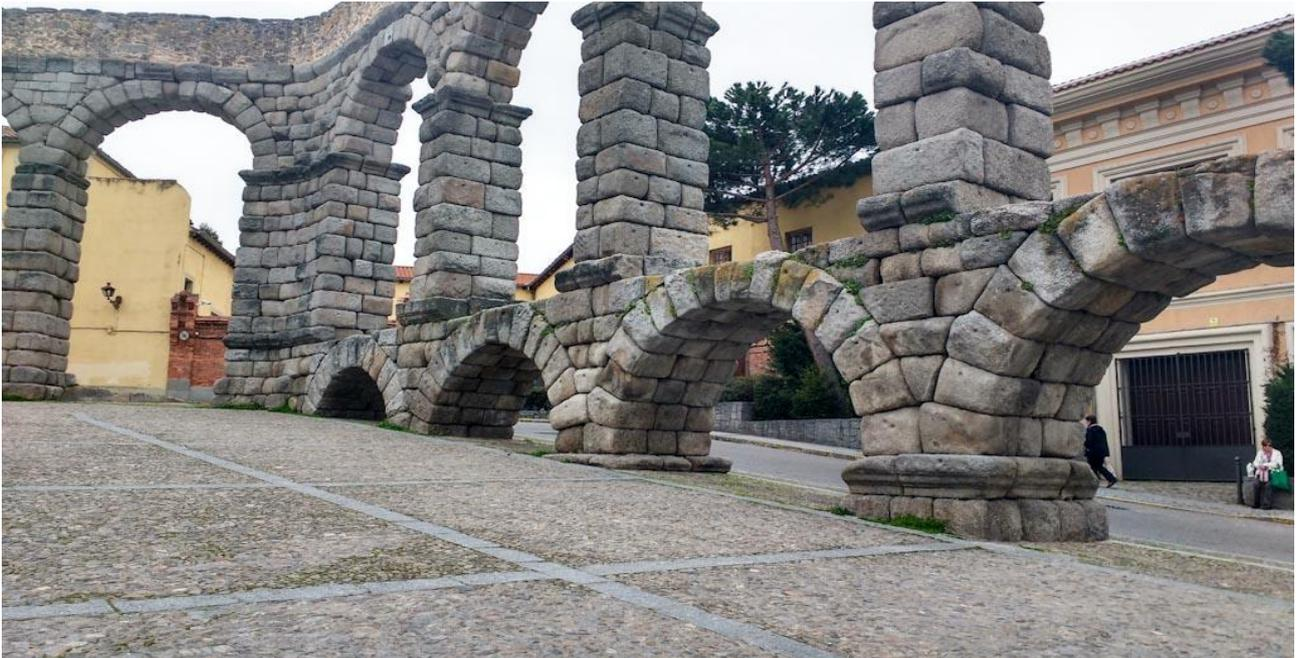
Está construido con grandes bloques de piedra sujetas gracias a la fuerza que ejercen unas sobre otras, sin utilizar ningún cemento ni nada similar y utilizando tenazas, andamios y la técnica de poleas para subirlas.
