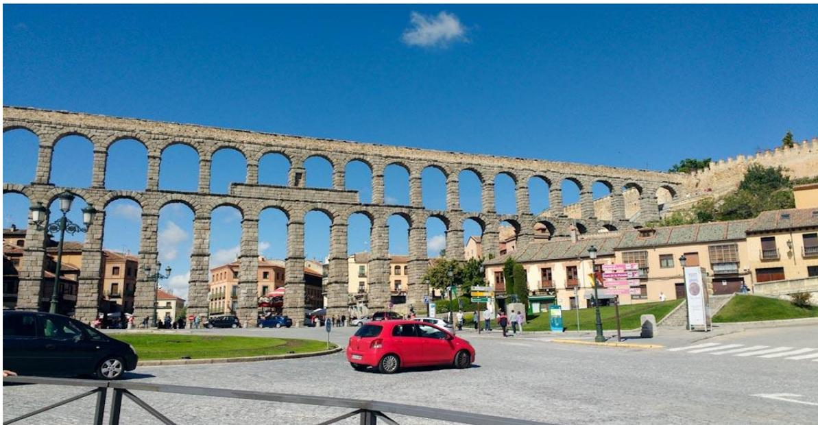
En la zona superior se albergaban las tuberías del agua que desde el manantial de la Fuentefría, situado a unos 17 km de la ciudad, se distribuía por todos sus barrios. La altura máxima de la construcción se alcanza en la Plaza del Azoguejo con 28,10 m de altura.
