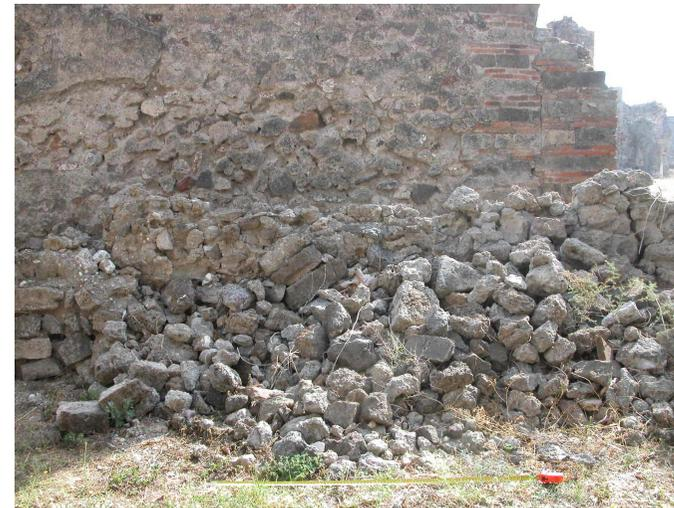
Derrumbe del muro oriental del pasillo que comunica el *triclinium* con la planta semienterrada.
