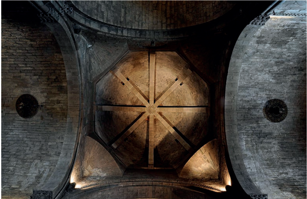
Fig. 9. Bóvedas y cúpula del crucero de la catedral de Jaca (foto: autor)
