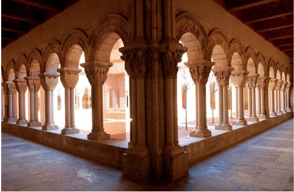
Fig. 8. Galerías del claustro de Santa María de Tudela. Panda oeste y panda sur Foto: E. Lozano
