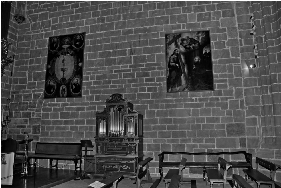
Fig. 5. Muro meridional del transepto en cuyos extremos se aprecian vestigios de la fábrica románica.
