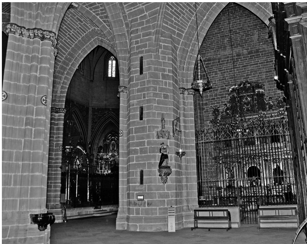
Fig. 11. Machón gótico de la catedral de Pamplona que contiene la escalera de caracol románica.
