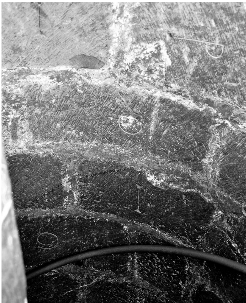
Fig. 10. Sillares románicos con marcas de cantero en el interior de la escalera de caracol.
