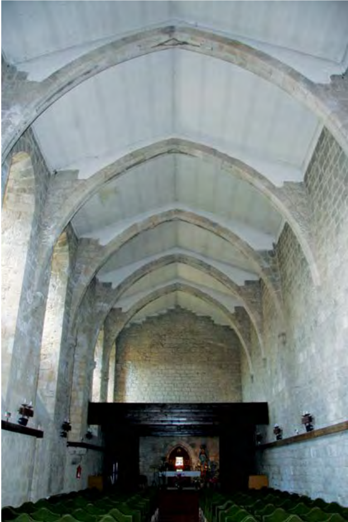
Santo Domingo de Estella: vista del interior del antiguo refectorio.
