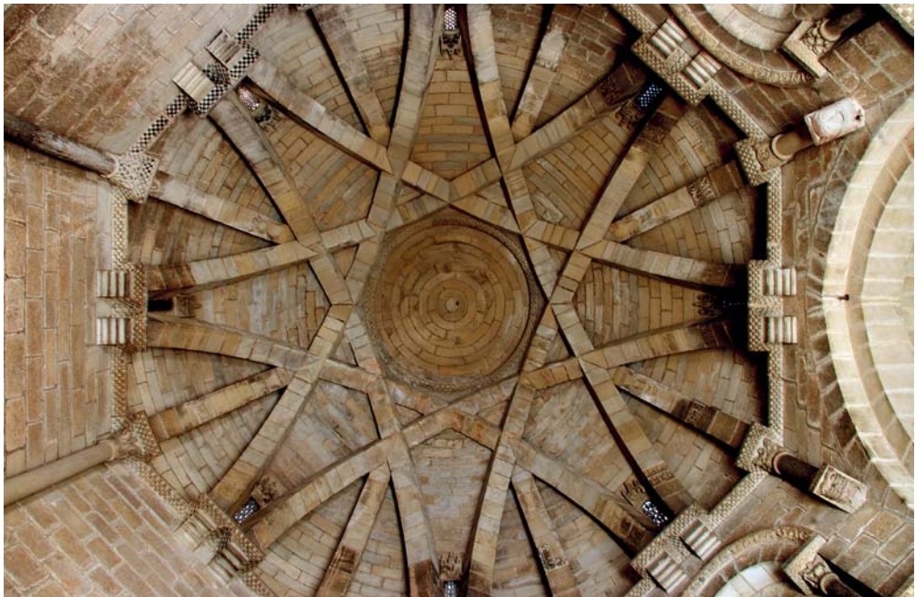
Fig. 13. Cúpula de nervios de entrecruzamiento periférico del Santo Sepulcro de Torres del Río (Foto: autor)
