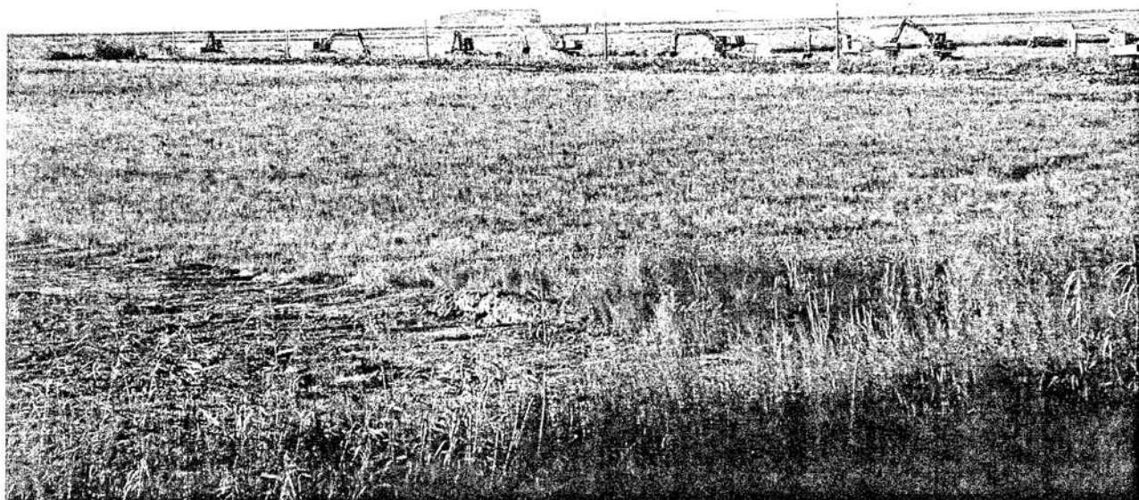
Maquinaria empleada en la retirada de lodos.
