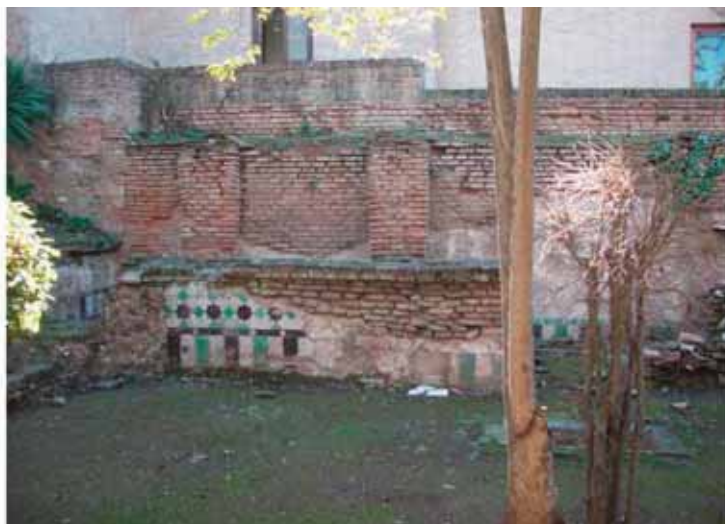
Figura 3. Estado previo a la intervención arqueológica
