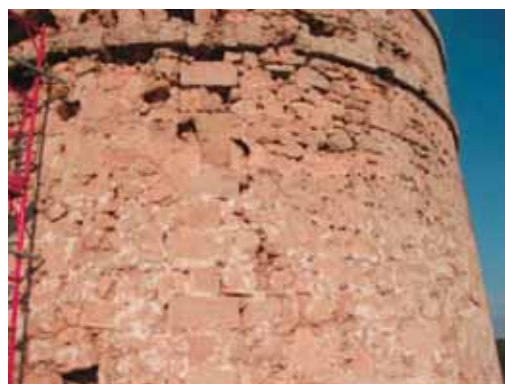
Fig. 10. Paramento sin restaurar (3)
