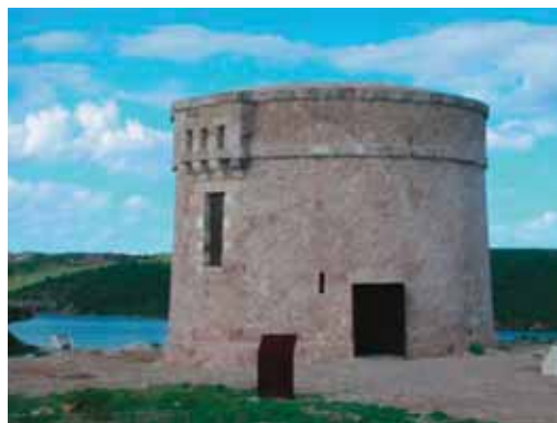
Fig. 19. Aspecto de la Torre Cala Teulera tras las obras de restauración
