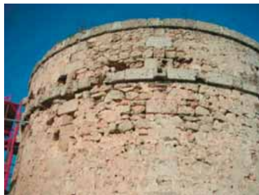
Fig.9. Paramento sin restaurar (2)
