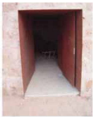
Fig. 13. Vista de la puerta restaurada
