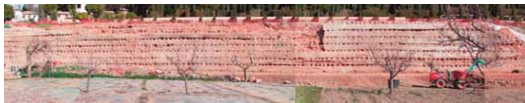
Figura 6. Estado del alzado del muro de la parata tras la limpieza completa y la excavación
