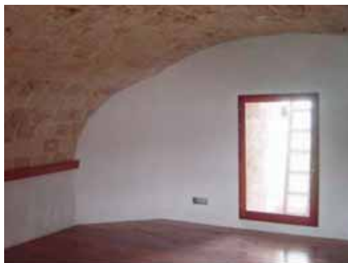
Fig. 15. Interior después de la restauración
