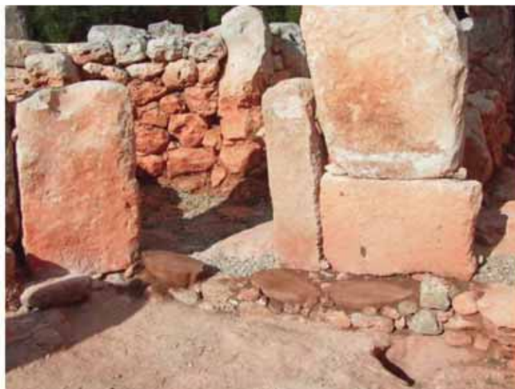
Figura 12. Reconstrucción de la banqueta
