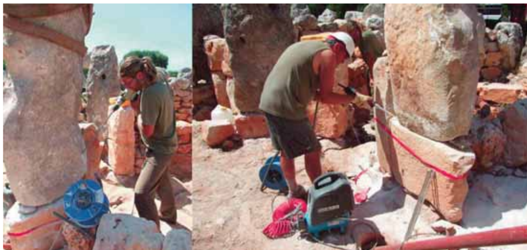
Figura 10. Trabajos de consolidación de los grandes bloques
