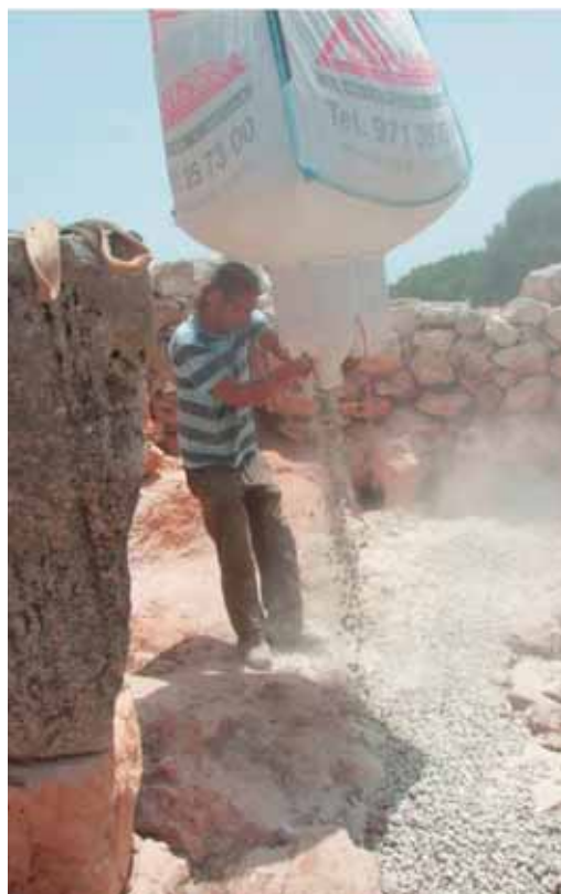
Figura 14. Nivelación con grava
