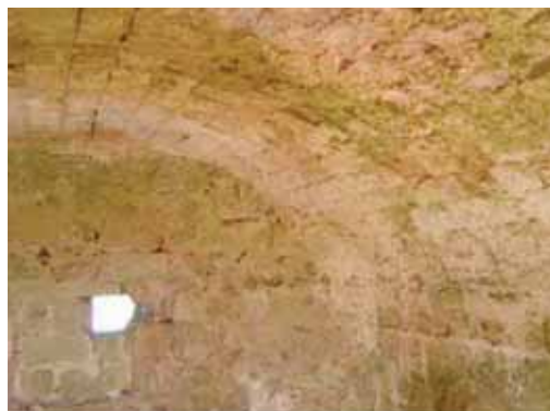
Fig. 14. Interior antes de la restauración
