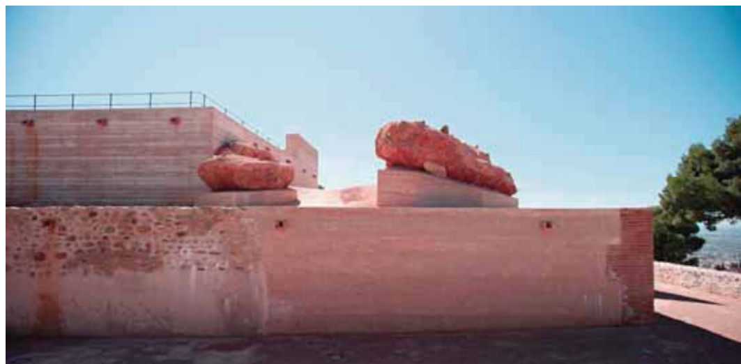
Figura 10. Vista de los restos de hormigón árabe situados en el segundo nivel con la torre mirador al fondo. Fotografía: Javier Callejas Sevilla
