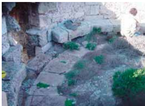
Fig. 17. Cubierta antes de la restauración. Banco perimetral
