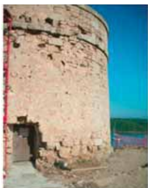
Fig. 8. Paramento sin restaurar (1)
