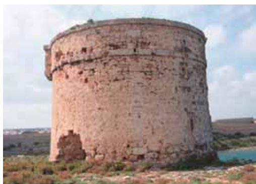
Fig. 1. Vista general Torre Cala Teulera (1)
