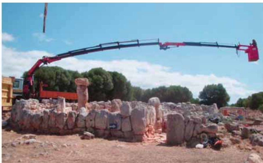
Figura 6. Camión grúa con la cesta para hacer las fotos cenitales
