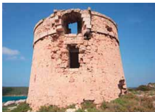
Fig. 2. Vista general Torre Cala Teulera (2)
