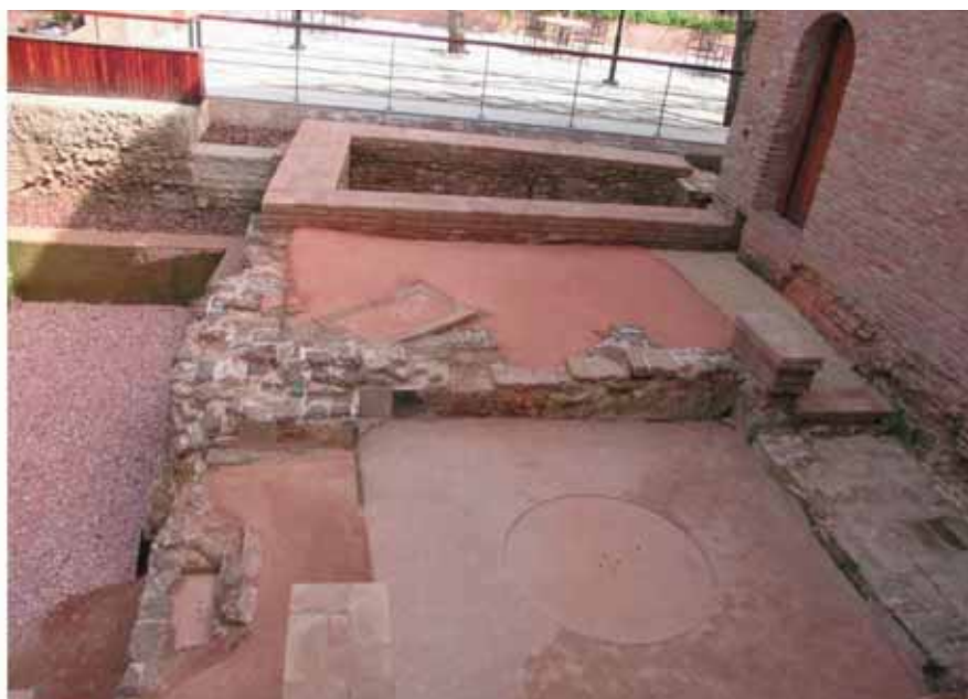
Figura 8. Acabado de protección de bañera con baldosas de barro
