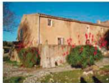
Aspecto antes de la rehabilitación
