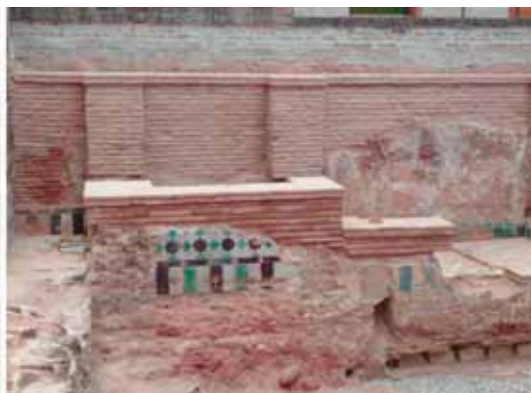
Figura 9. Proceso de des-restauración y de construcción de recrecidos nuevos
