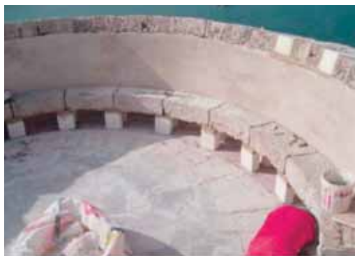
Fig. 18. Cubierta después de la restauración. Banco perimetral.
