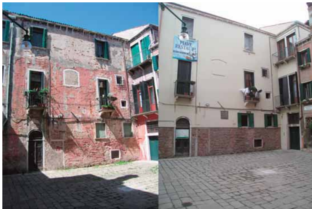
Figura 2-3. Imagen de la fachada antes y después de la intervención y de la sustitución del mortero de yeso.
