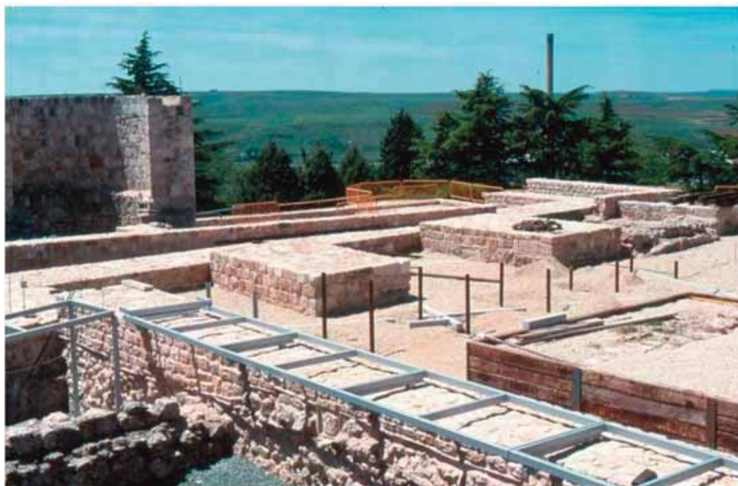
Figura 8. Montaje de las pasarelas del recorrido actual simplemente apoyadas
