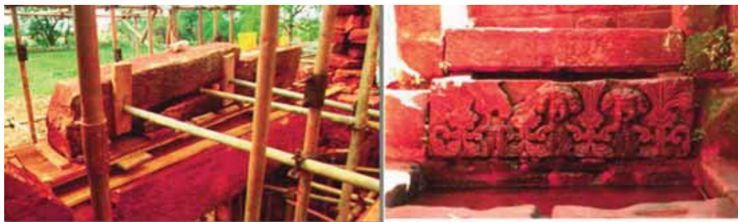
Figuras 9, 10. Diferentes vistas de los trabajos de consolidación en la fuente.
