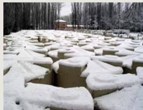
Las estaciones están construidas con material plástico resistente para poder aguantar las inclemencias del clima e incluso golpes severos. Una de las características del proyecto Pierre Auger es su integración en el entorno.
