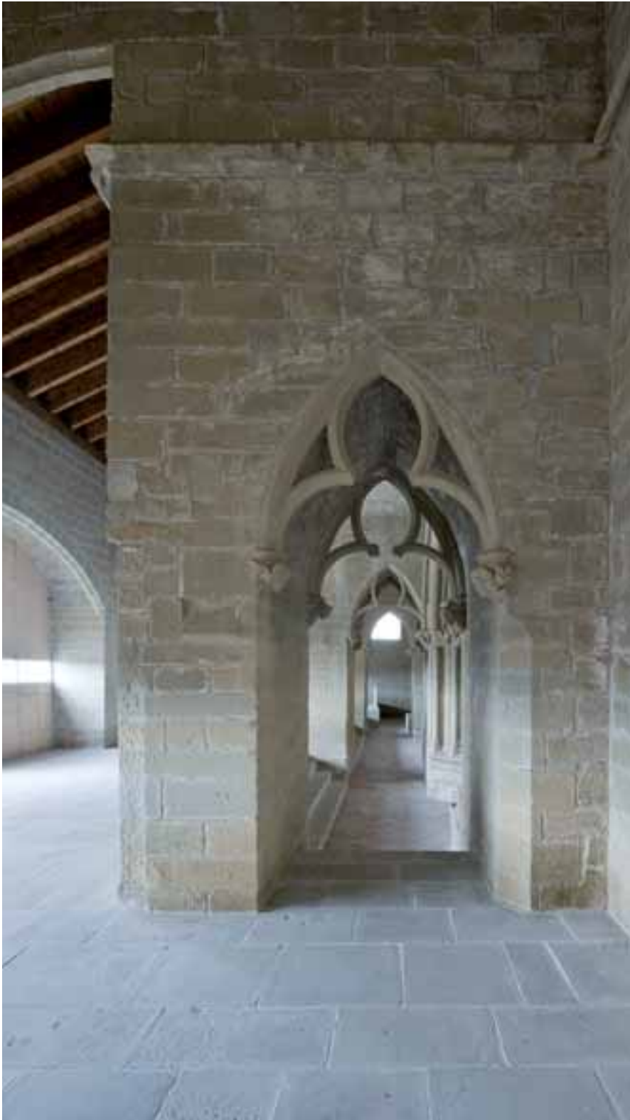
Circuito conseguido mediante pasajes abovedados que atraviesan los contrafuertes
