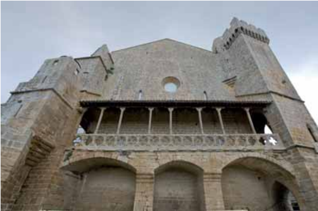
Fachada occidental con la galería
