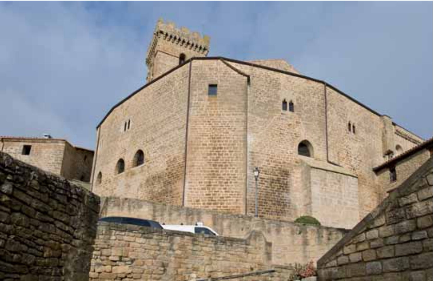
Exterior del muro perimetral
