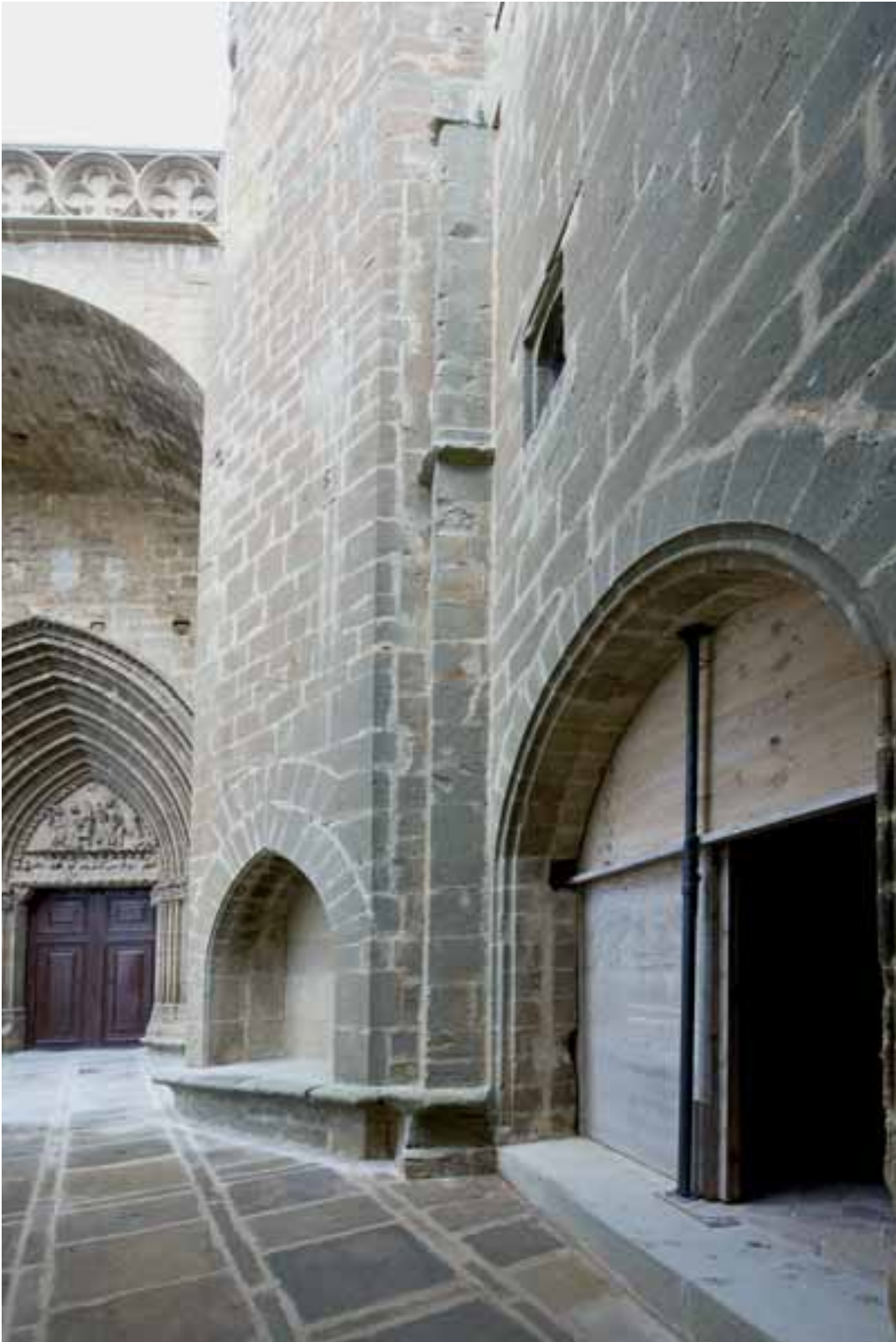
Vista exterior de la torre; en la parte baja se aprecia el encuentro de los paramentos románico y gótico
