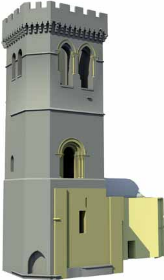
Torre románica reedificada en época gótica
