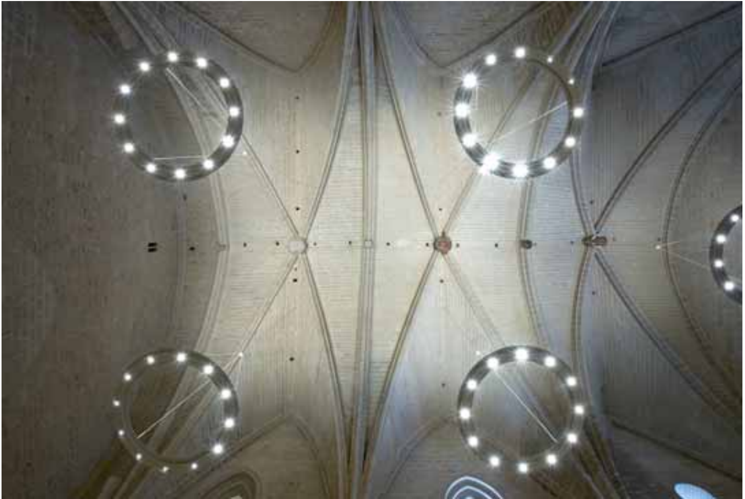
Tramos de bóveda de la gran nave gótica
