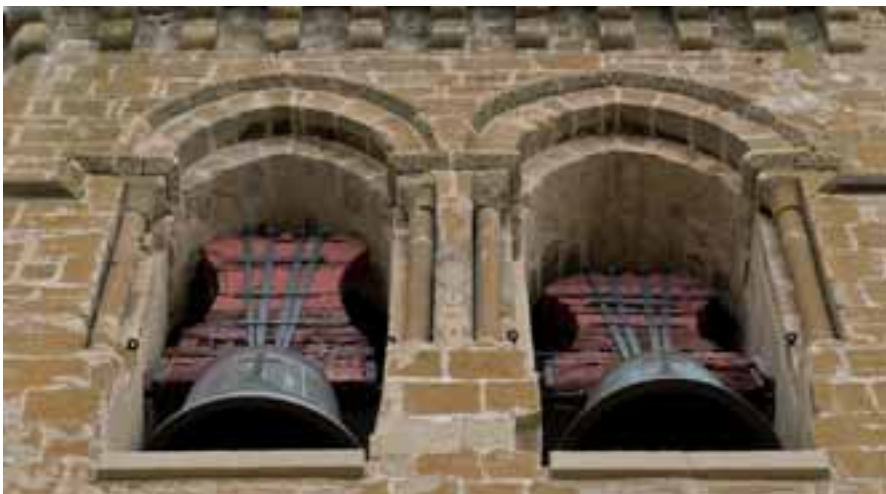
Elementos tardorrománicos reemplazados en los vanos góticos del piso superior de la torre (cara sur)
