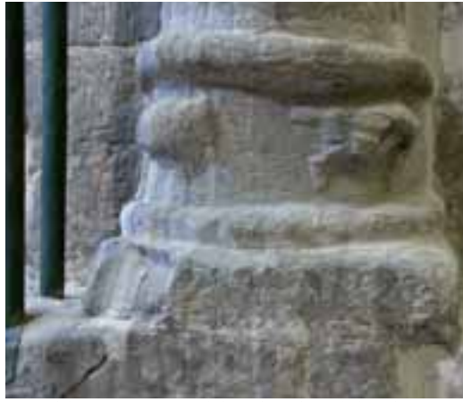
Basa del arco septentrional de embocadura de la cabecera románica
