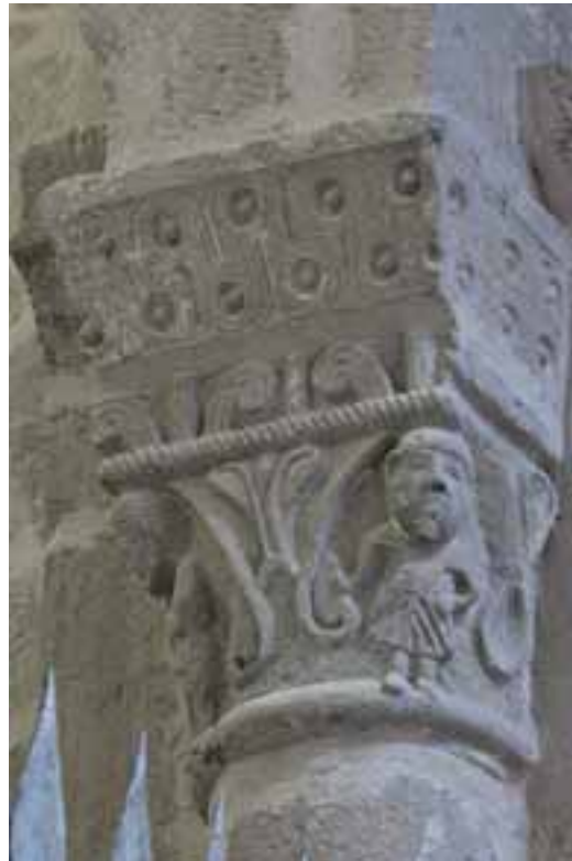
Capitel del arco central de embocadura de la cabecera románica (lado sur)
