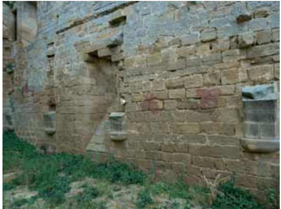
Muro meridional del “colegio” en que se aprecian las ventanas y los arranques de los arcos
