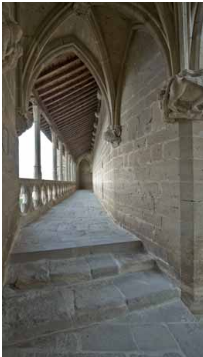
Galería occidental vista desde el ángulo sur
