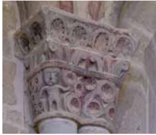
Capitel de la arquería interior de la capilla mayor
