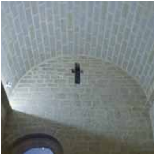
Ventana cruciforme sobre el arco de embocadura de la capilla septentrional (vista interior)
