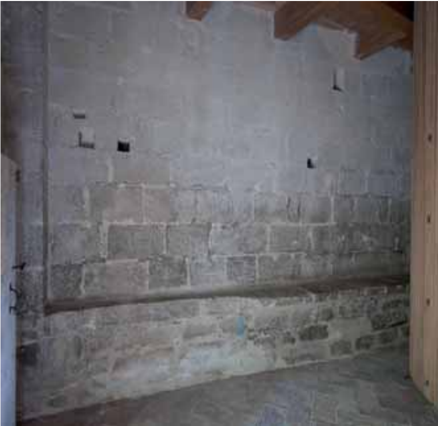
Muro meridional de la torre románica: exterior de la planta baja
