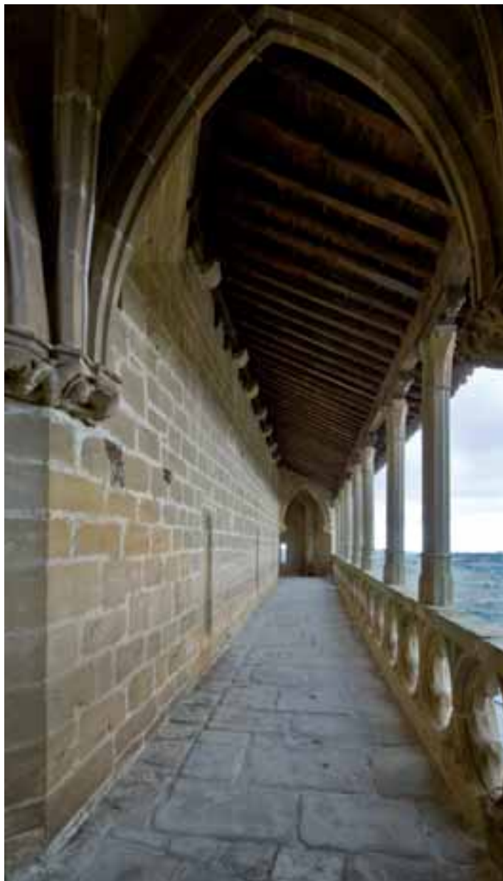
Galería occidental vista desde el ángulo norte
