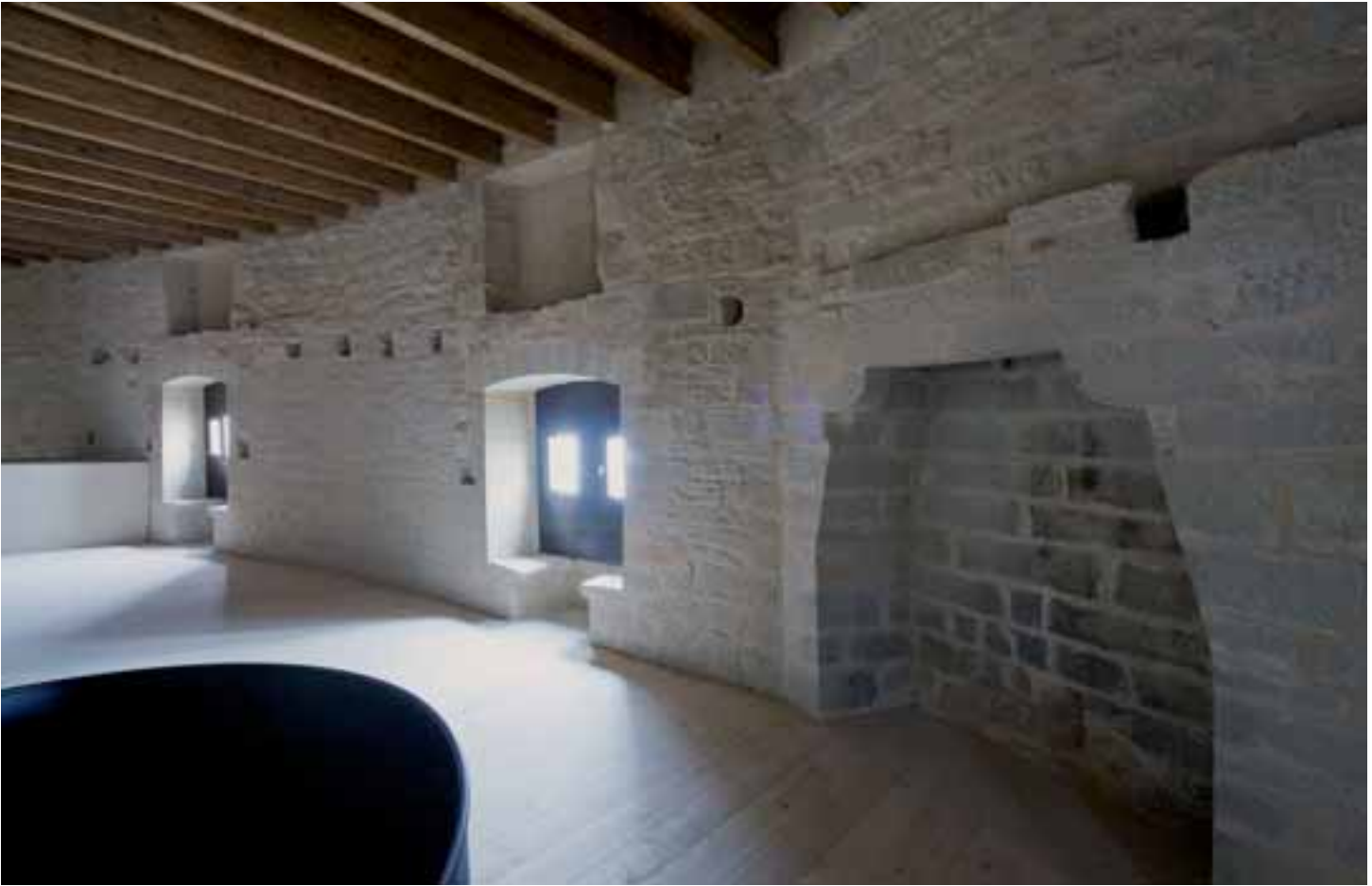
Chimenea y miradores en las estancias residenciales habilitadas gracias al muro perimetral
