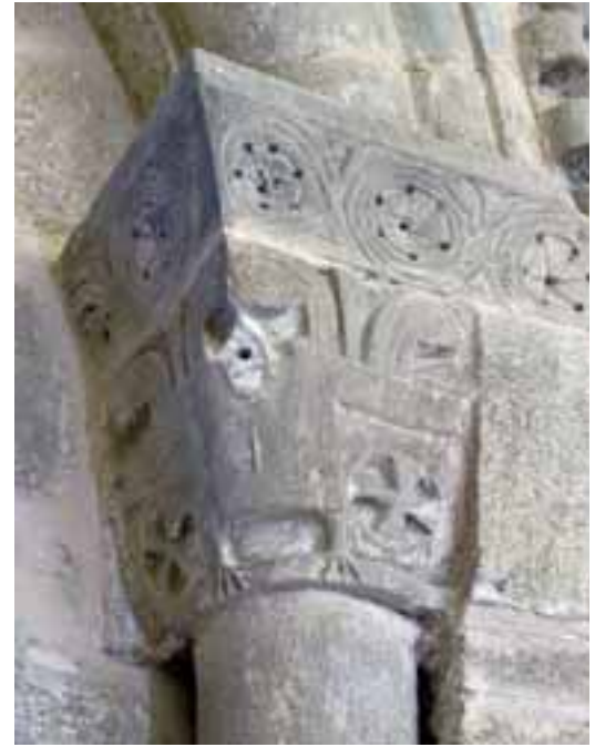
Capitel con ave de la ventana del ábside septentrional (interior)
