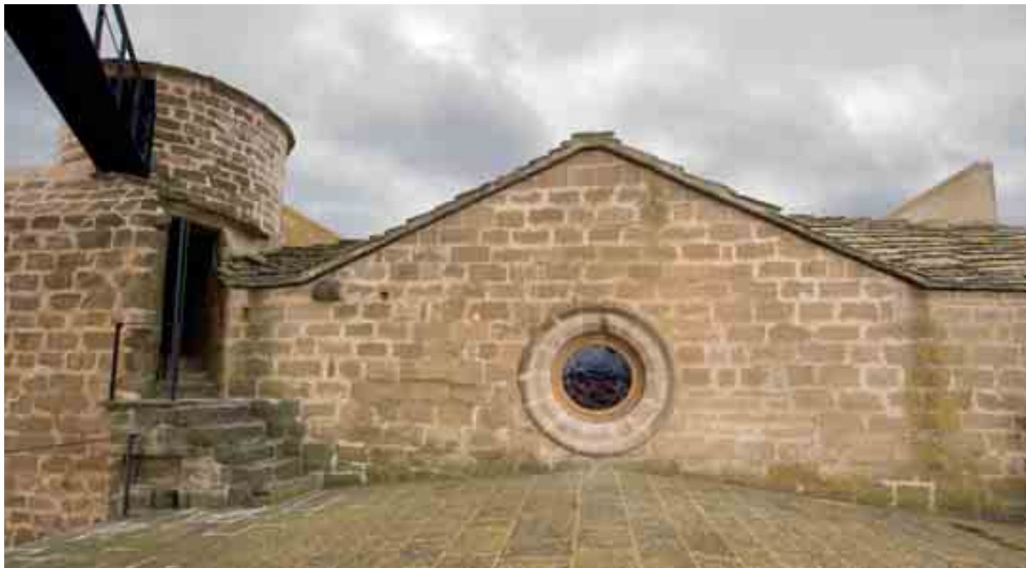
Remate oriental de la nave y escalera de acceso a cubiertas
