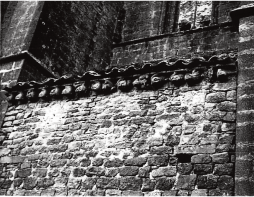
Elementos de la portada septentrional integrados en la capilla del Cristo antes de su restauración
