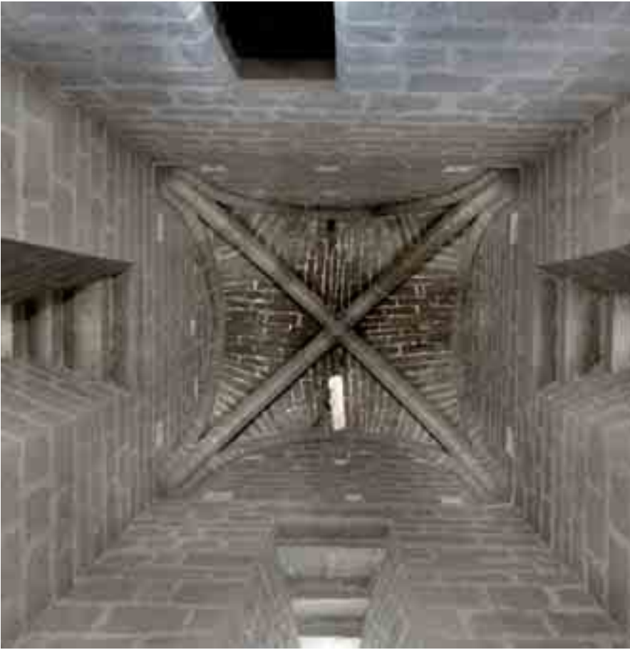
Bóveda de la cámara superior de la torre
