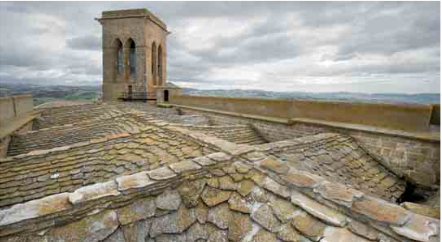
Vista de conjunto de la cubierta y el parapeto defensivo
