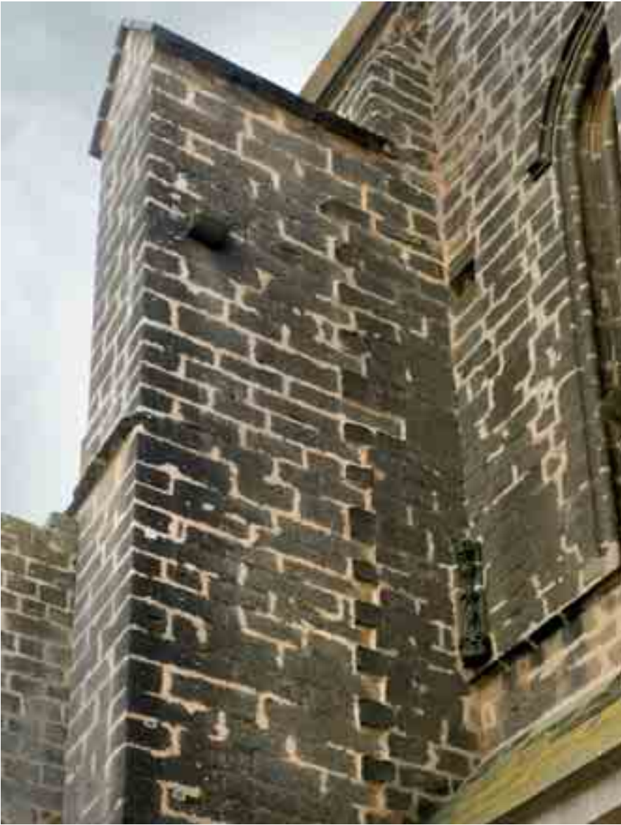
Detalle de contrafuerte recrecido
