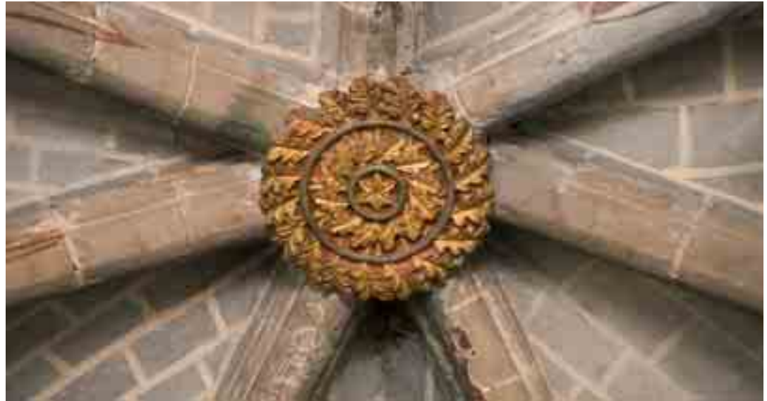
Clave de bóveda de la capilla mayor
